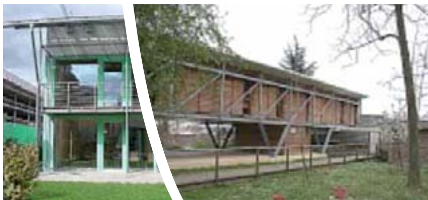
Construction sur poteaux béton
