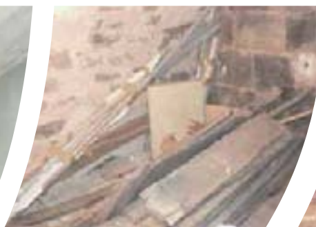
Exemple d'encombrement dans une cave
